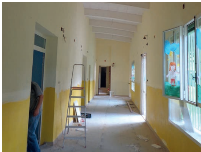
Lavori di ristrutturazione Scuola Madonna del Carmine Imola
